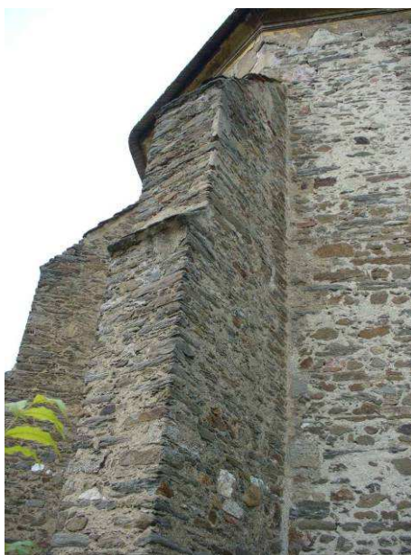
Horní část opěrného pilíře na východní straně kostela
