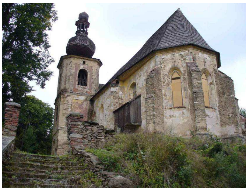
Celkový pohled na kostel od východu
