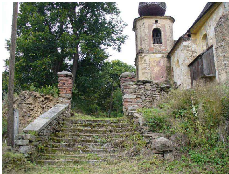
Schodiště na východní straně kostela
