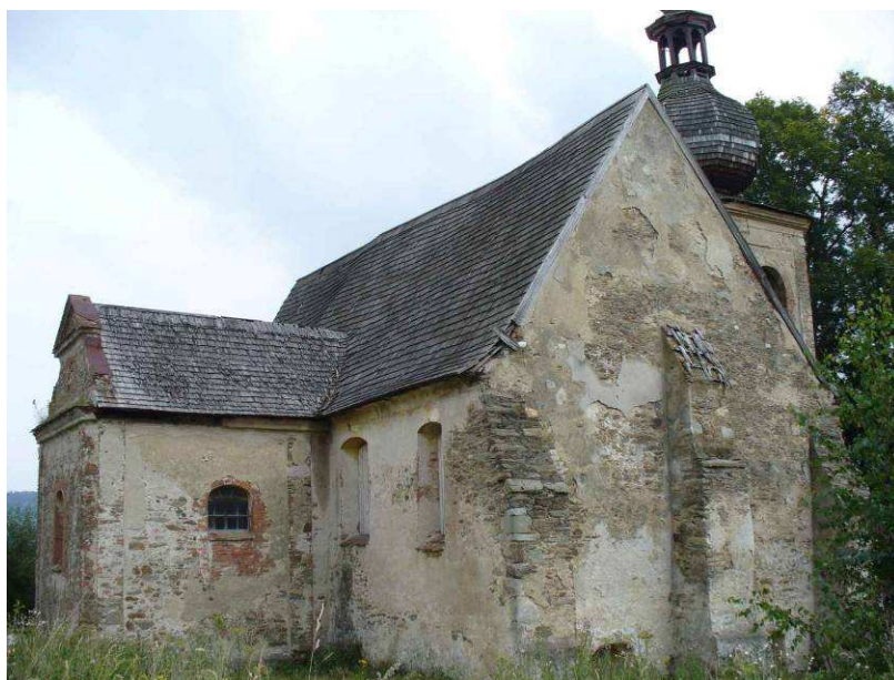
Celkový pohled na západní štít a křestní kapli
