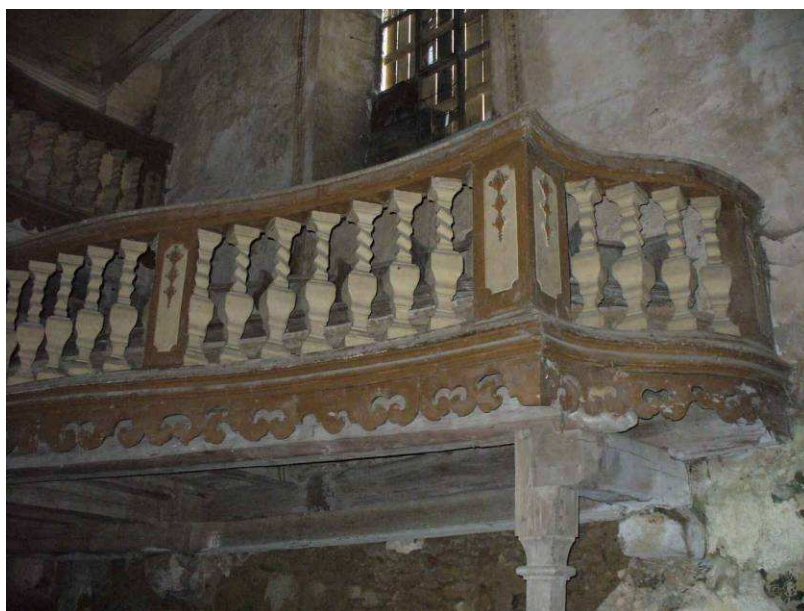
Pravé křídlo 1. patra kruchty
