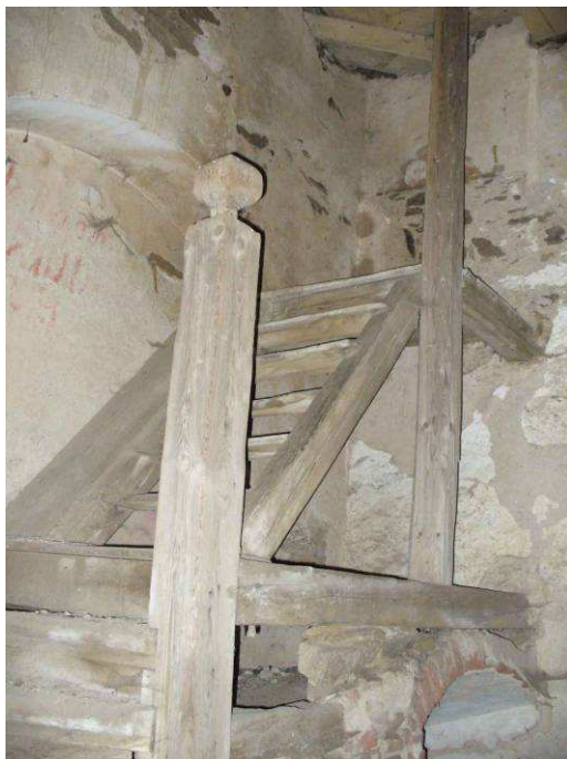
Schody vedoucí do 2. zvonového patra věže
