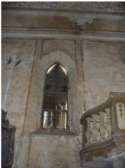
Interiér hlavní lodi s gotickým oknem
