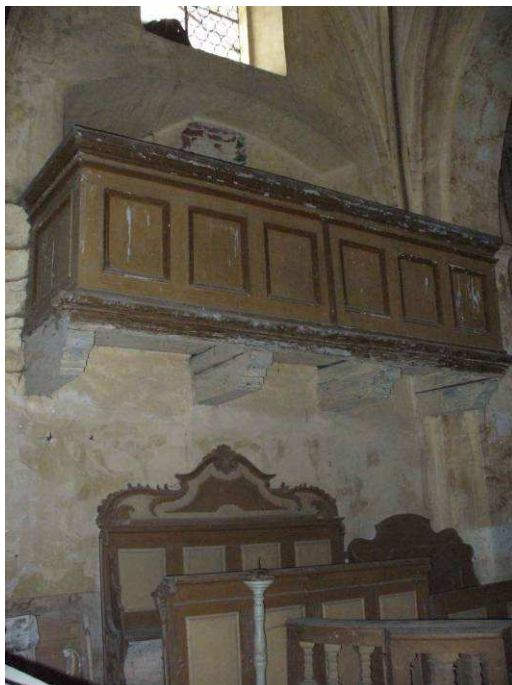
Jižní stěna presbyteria s oratoří
