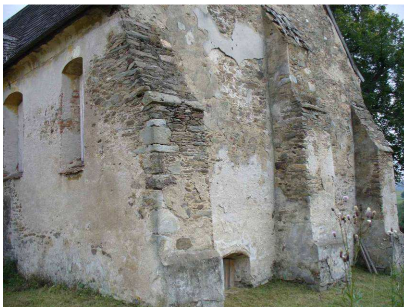
Opěrné pilíře na západní straně kostela
