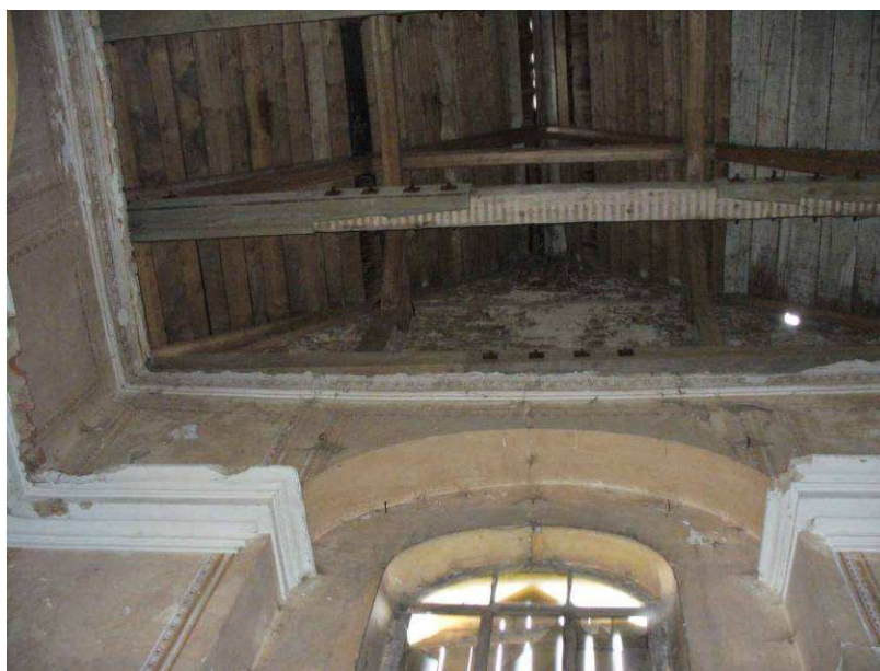
Pohled na strop křestní kaple s odkrytým krovem
