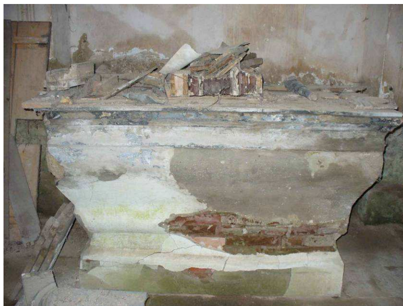
Cihelná menza v prostoru křtící kaple
