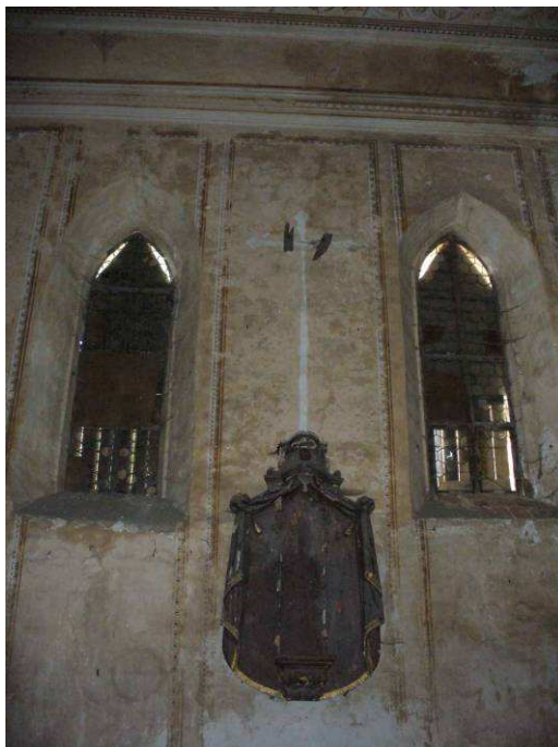
Interiér hlavní lodi s gotickými okny a dřevěným baldachýnem
