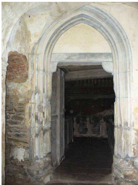
Původní hlavní vstup s gotickým portálem v prostoru přízemí věže
