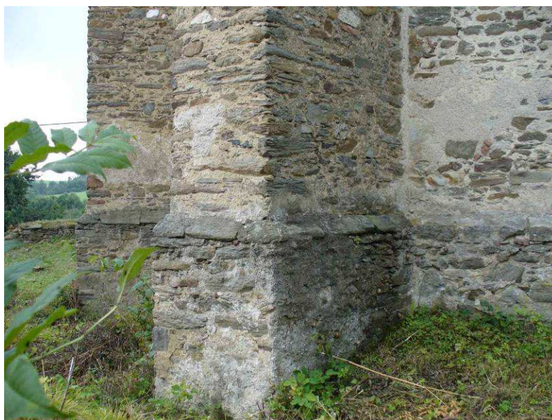
Spodní část opěrného pilíře na východní straně kostela
