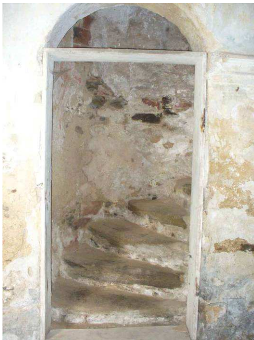
Schodiště do věže
