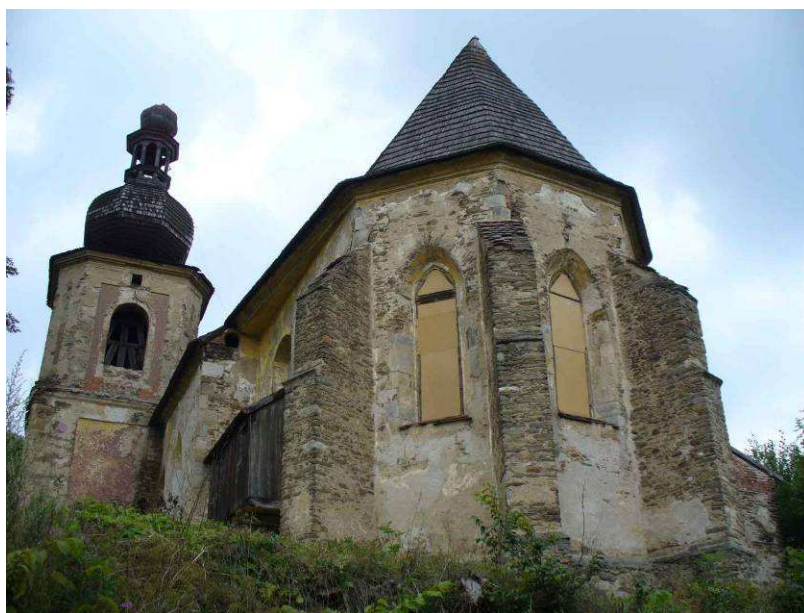
Pohled na presbyterium kostela
