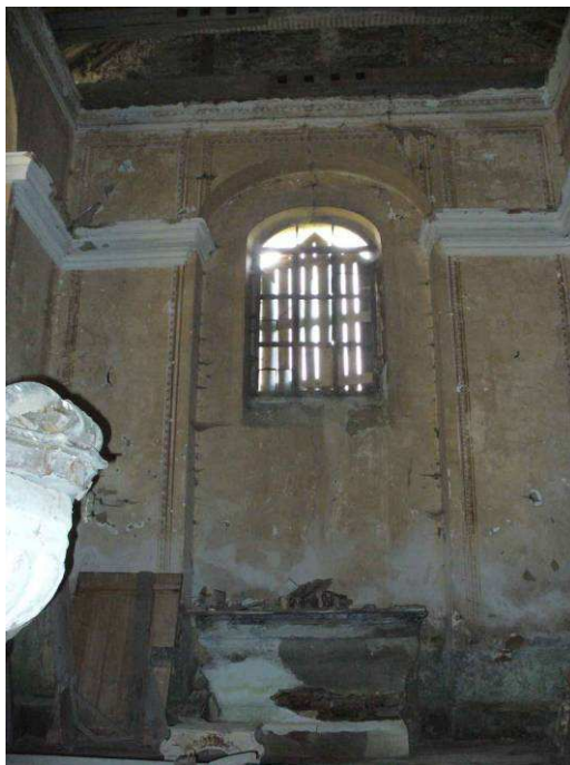
Pohled do křestní kaple
