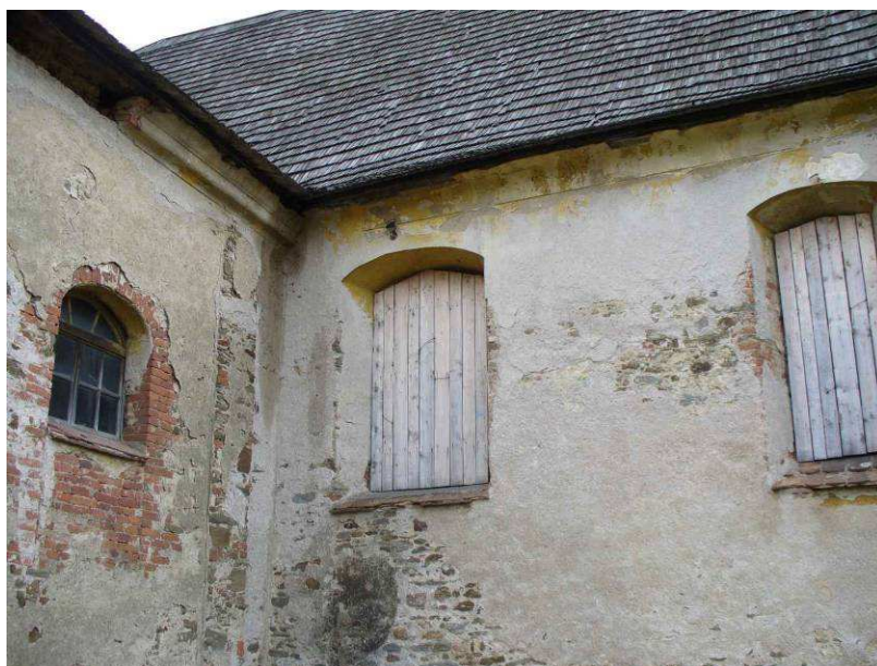
Severní stěna hlavní lodi s okny
