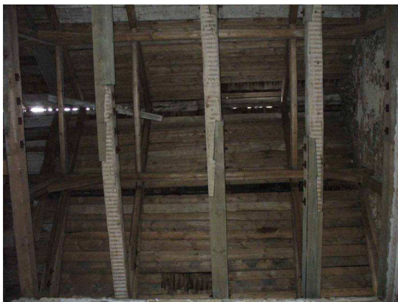
Odkrytý krov křestní kaple
