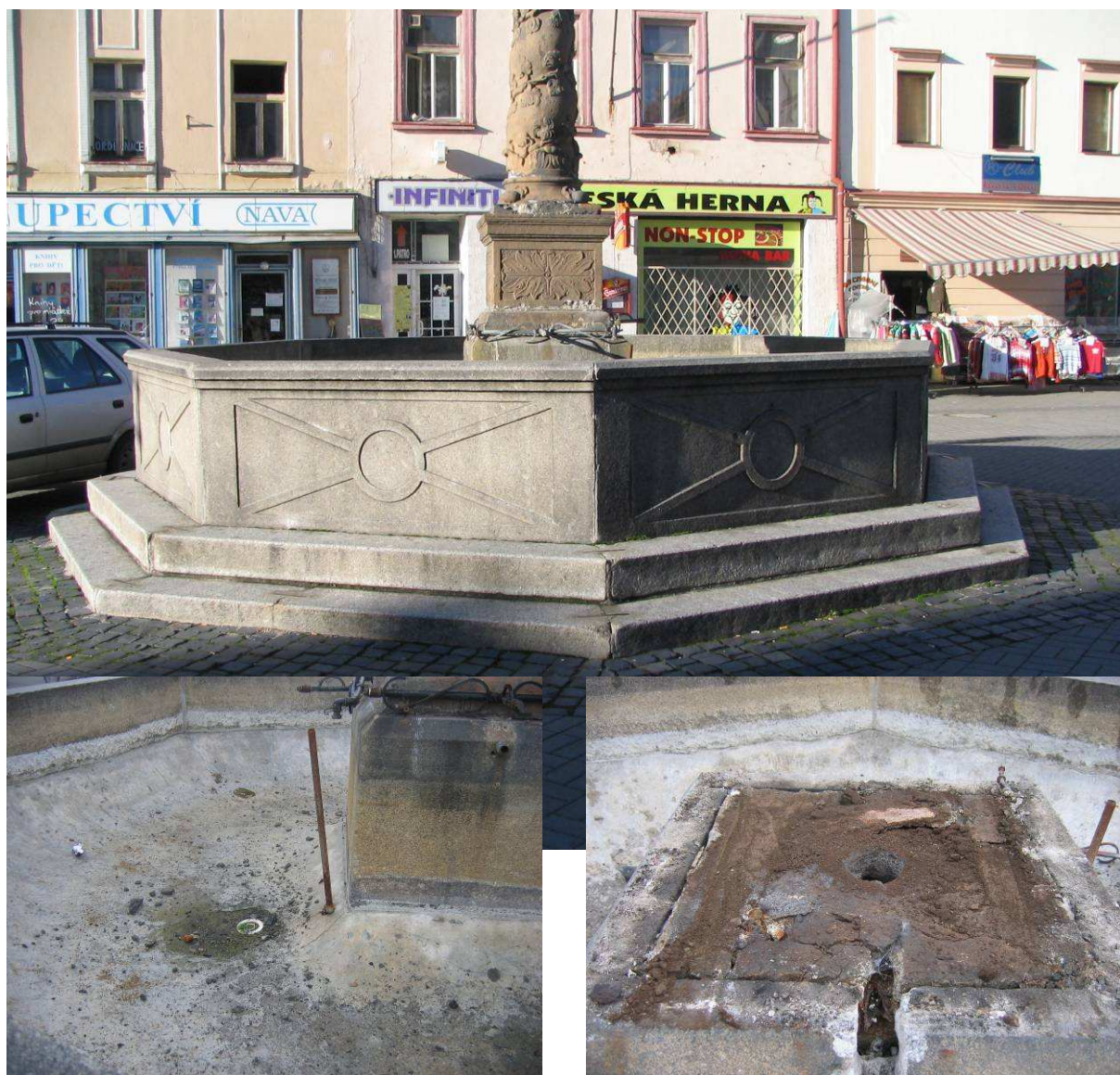
Celek nádrže, detail betonové výplně dna a podstavce z žulových desek, který ukrývá původní kamenný podstavec
